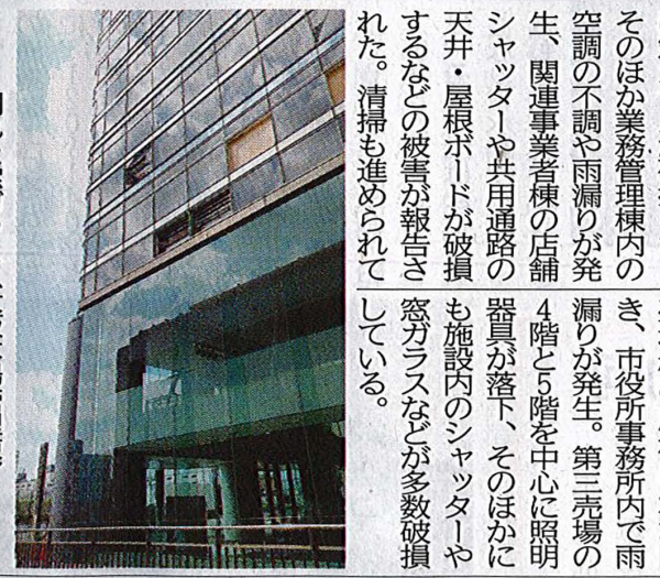
割れた窓ガラス(大阪本場管理棟)
